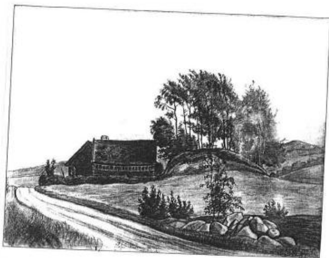
Lugnarshögen 1916 efter teckning av Holger Havrehed. Byggnaden med stegen riven sedan teckningen kom till. Foto: Lennart Lundborg.
